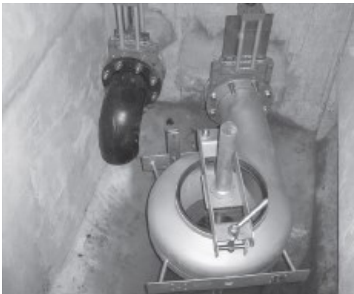
Obr.7: Regulační šachta s vírovým regulátorem FluidVortex typ HSU 3 DN200, dimenzovaný odtok Q = 21 l/s
